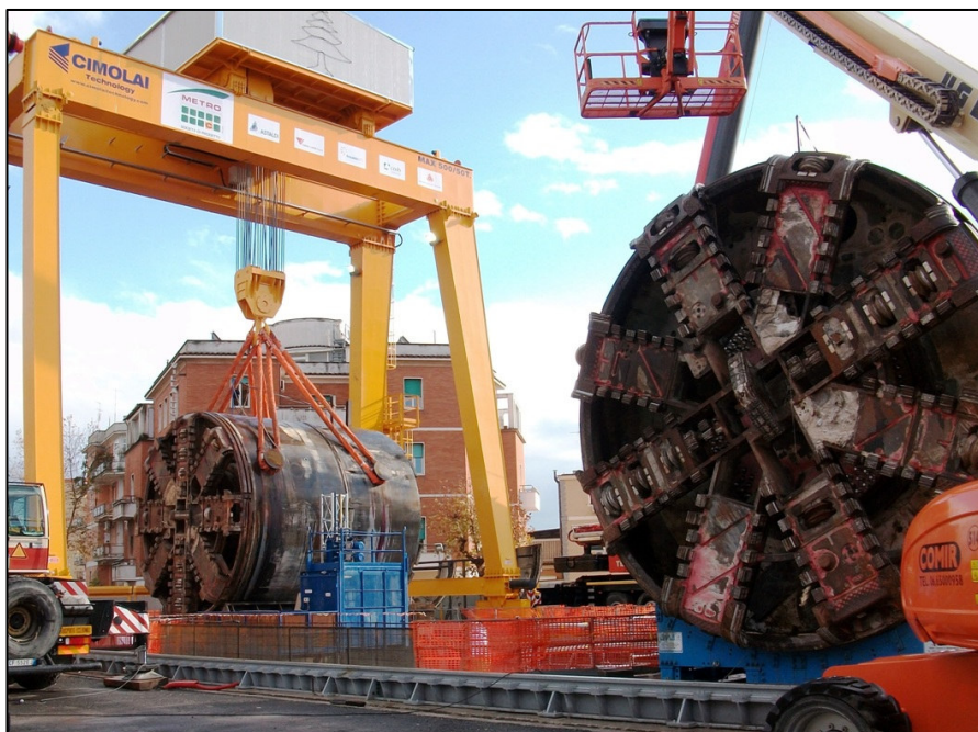
< le TBM 1 e 2 al cantiere di San Felice da Cantalice.
