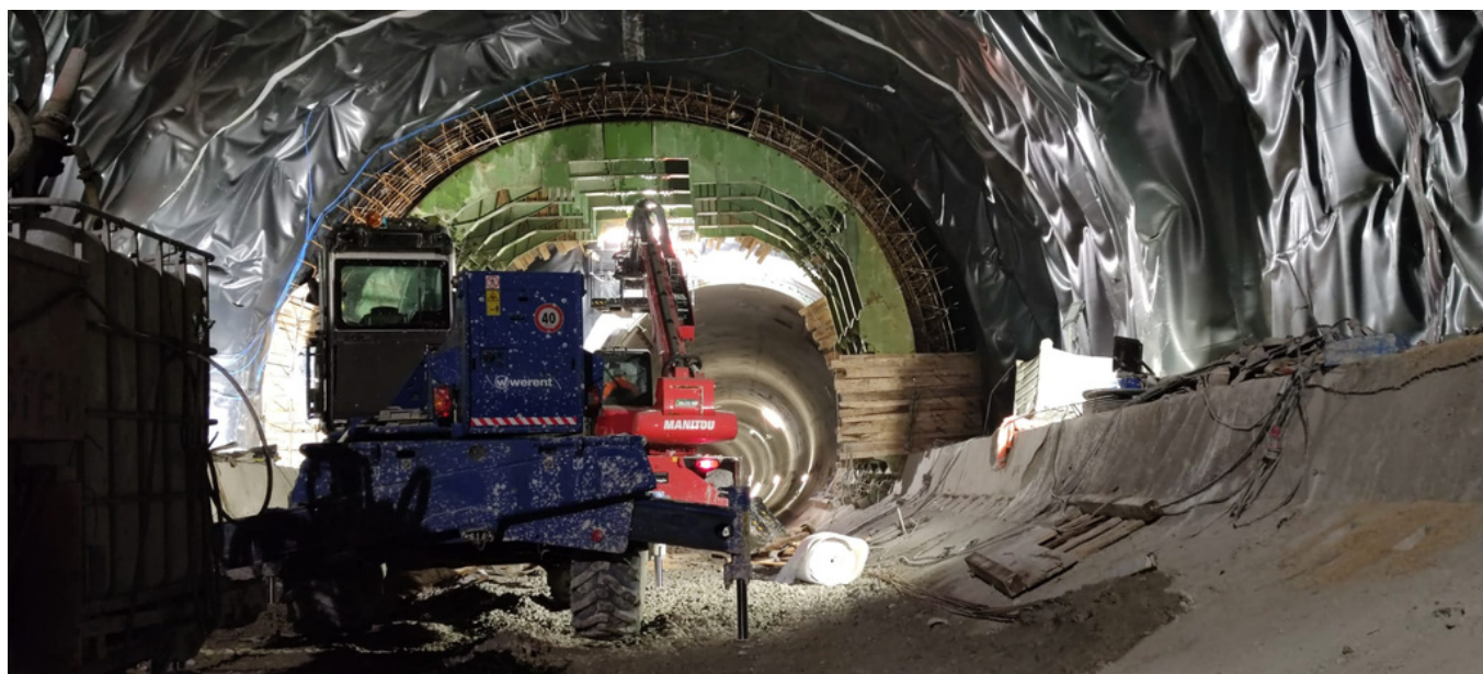
Pozzo 3.2 - Celimontana - Galleria in allargo Binario Dispari in direzione Fori Imperiali
