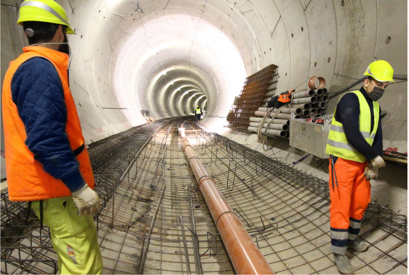
Cantiere Fori Imperiali - Binario Pari - lato Celimontana - solettone di regolamento
